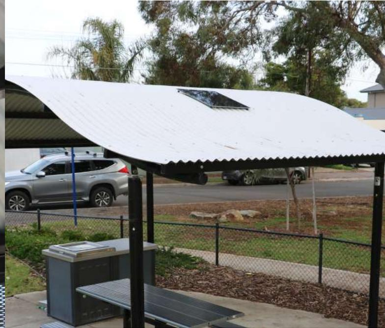
**THE SEPERATE PANEL DESIGN** ALLOWS SOLAR POWERED ILLUMINATION
